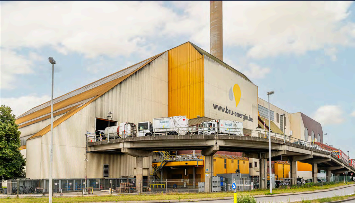
Les petits déchets, vers l’unité de valorisation énergétique, les gros déchets, via « un centre de tri ».
